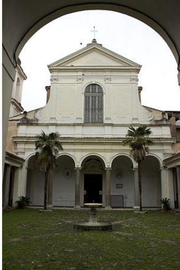
Fachada vista do átrio
